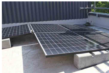
Pose des panneaux sur la toiture de l'atelier Nunhems à Longué-Jumelles - Mai 2025
