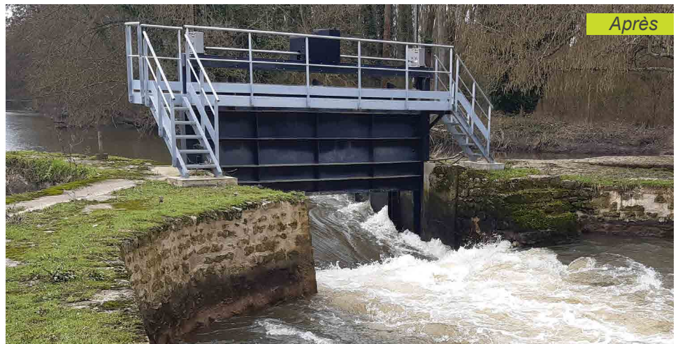
La nouvelle vanne mesure 4,5m de large sur 2m de hauteur
