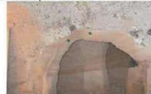
Fracture dans la voûte du passage. Blocage par deux broches acier en "couture".
