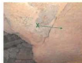
Front fracturé à stabiliser par un clou de type Split Set ou par un tirant passif court (2 m)
