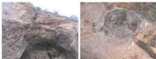
Voûte à renforcer par ancrages : tirants passifs courts (2 à 2.5 m)
