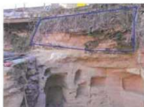
Restauration de la cohésion par réalisation d'une coque armée : Projeté chaux aérienne sur grillage
