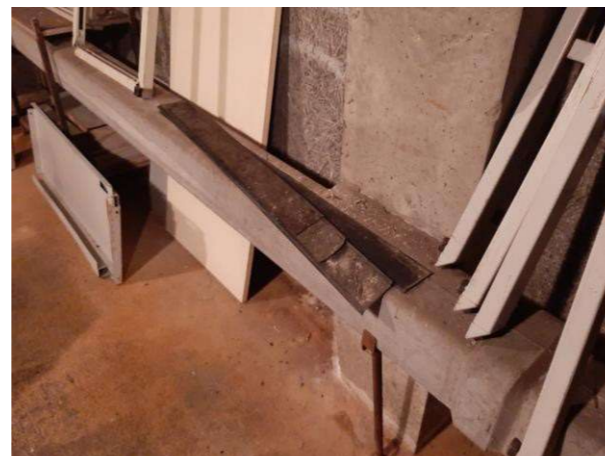
Gaîne amiantée dans le local de la chaudière
