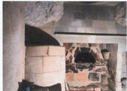
intérieur de la cavité (restauration de la cheminée en tuffeau datant de plusieurs siècles, four à pain, potager, buée (lavoir))
