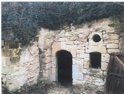
façade de l'ancienne habitation troglodytique
