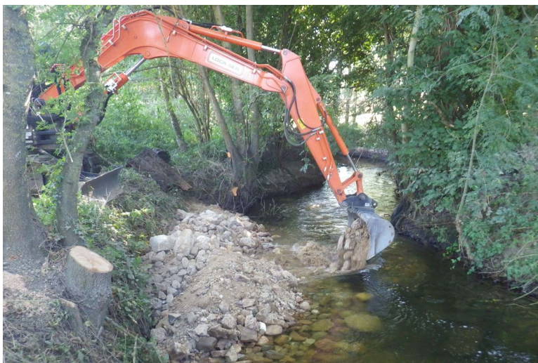
L'apport de matériaux alluvionnaires permet de diversifier les écoulements
