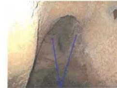
Zone de remblais, instable, sans cohésion. Stabilisation par élévation de maçonneries
