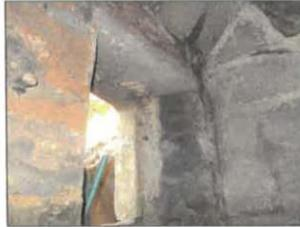
En point 6B, il conviendra d'assurer l'étanchéité entre la maçonnerie de façade et la voûte du troglodyte.
