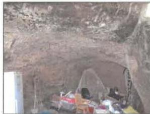
**\*Cave n° 2 :** Elle correspond à un petit ensemble dont une partie de la façade est maçonnerie, formant ainsi une pièce semi-troglodytique. Elle se développe sur une profondeur d'un peu plus de 3.50 m et sur un front de 4 m. La voûte s'établit à la cote relative +1 m, laissant subsister une épaisseur en recouvrement de l'ordre de 4 m.
