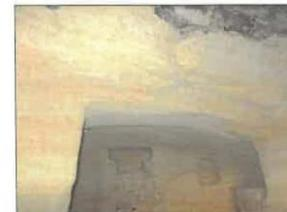
**\*Cave n° 9 :** Il s'agit d'une cavité développée globalement sur 5 m de profondeur qui pénètre légèrement sous l'impasse des Lauriers, avec une épaisseur en recouvrement de l'ordre de 3 m à ce niveau.
