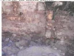
Base dégradée en en léger sous relief : à renforcer
