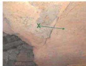
Front fracturé à stabiliser par un clou de type Split Set ou par un tirant passif court (2 ml)
