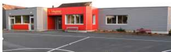
École après travaux
