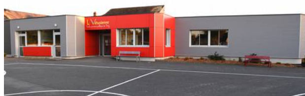
École après travaux
