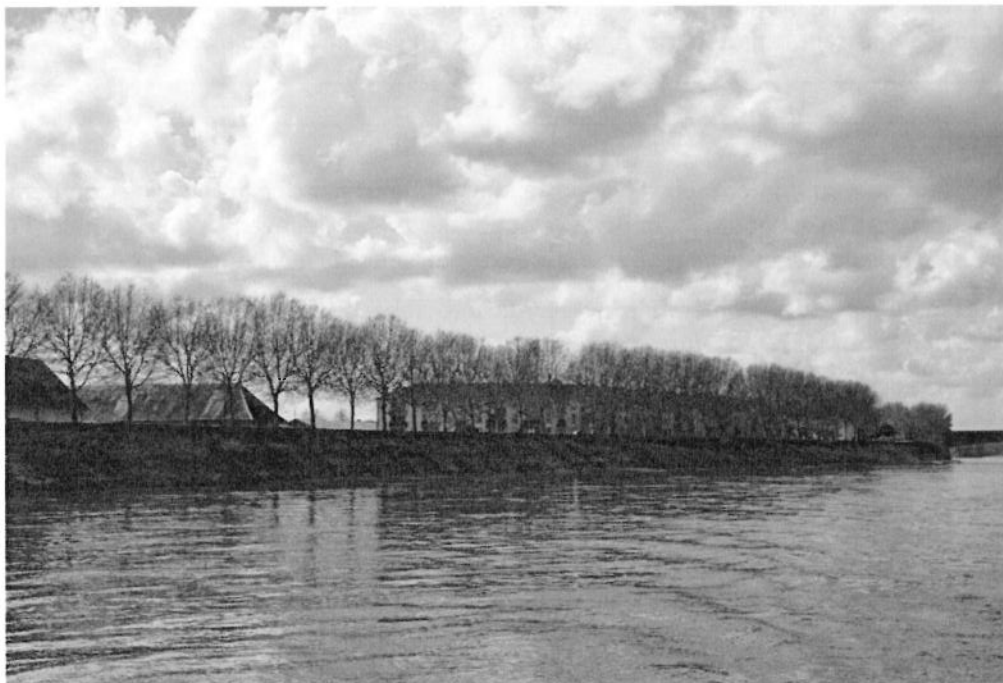
Digue de Saumur – tronçon du Chardonnet
